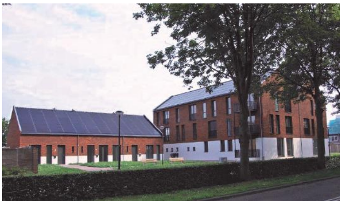
De nieuwe huurhuizen aan de Zuidsingel (33 appartementen én 17 woningen) zijn nagenoeg klaar. Foto Leo Willems
